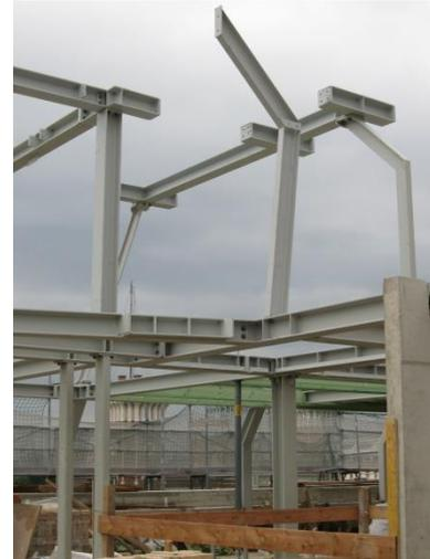
So wie bei diesem Projekt, stellt die Errichtung von Stahlbauten für diverse Dachgeschossausbauten einen Schwerpunkt der Gänsweider Metalltechnik GmbH dar. Am Schlickplatz in Wien wurden im Zuge dessen Stahlträger mit einem Gesamtgewicht von mehr als 90 Tonnen verbaut.
